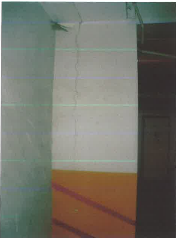
Зураг 26. Зоорийн давхарт блокуудын заагаар ан цав үүссэн байдал
