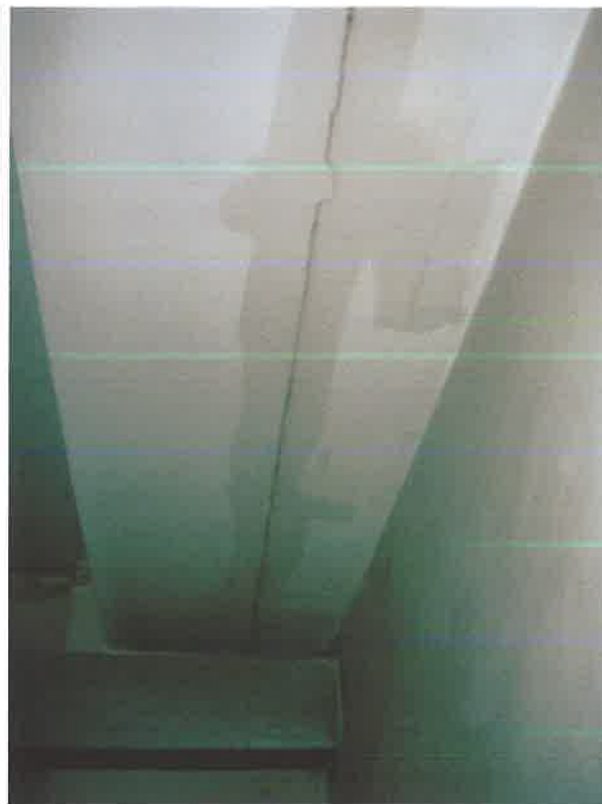
Зураг 27. Зоорийн давхарт блокуудын заагаар ан цав үүссэн байдал
